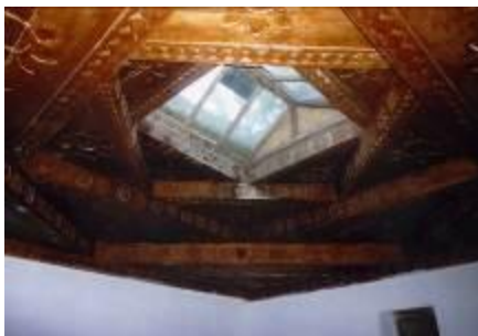
シャーヒ・マルダーン廟の天井
