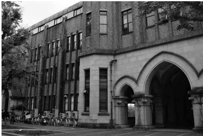
本プログラムが設置されている法文2号館
