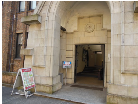
法文2号館入口
