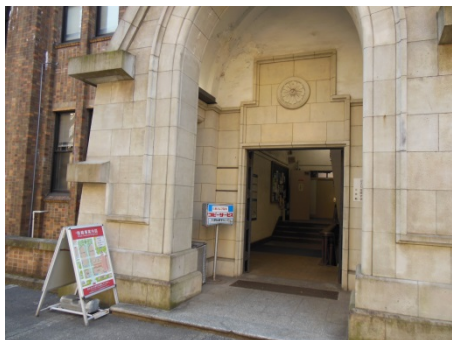
法文2号館入口
