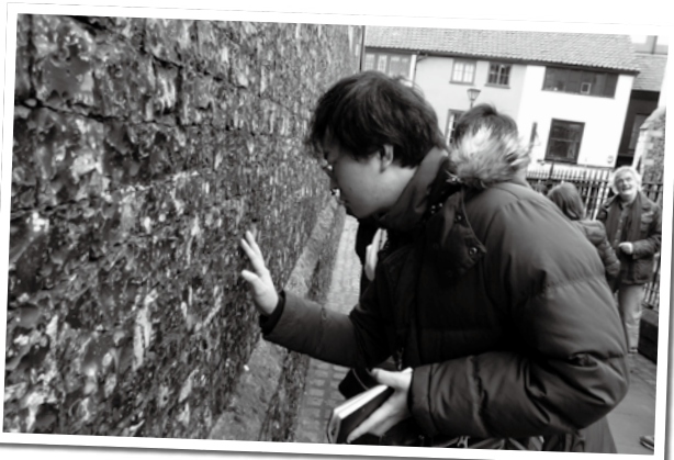
ノリッチ街中にある建物。壁には一面のフリントが使われている
